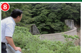
砂防ダムから流出土砂を確認
